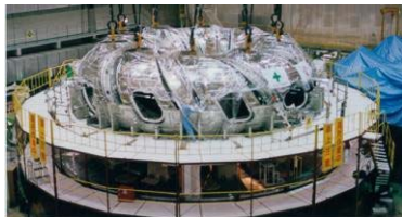
図 1-2 核融合マグネット (5kV, DC, 4.2K)
